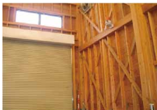
写真6 ホーンスピーカー取付状況
