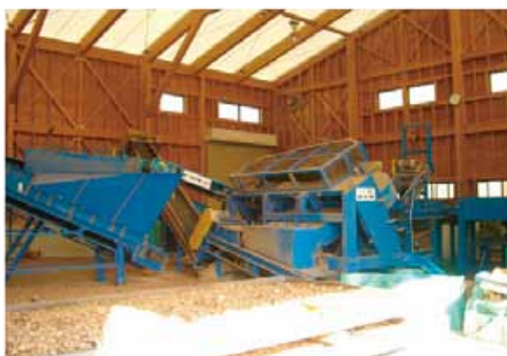
写真5 カッターミルとチッパー
