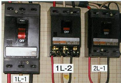
(写真2：送り先分電盤表示のあるブレーカ)
