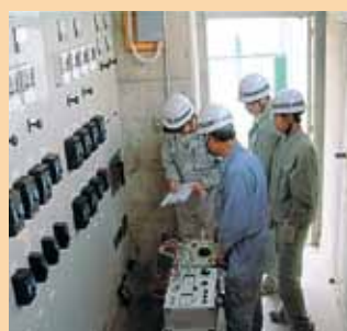
継電器試験実習
