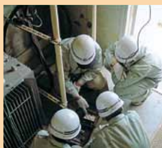
接地抵抗測定実習
