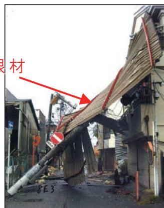
飛来物による電柱倒壊被害（平成30年台風21号）
